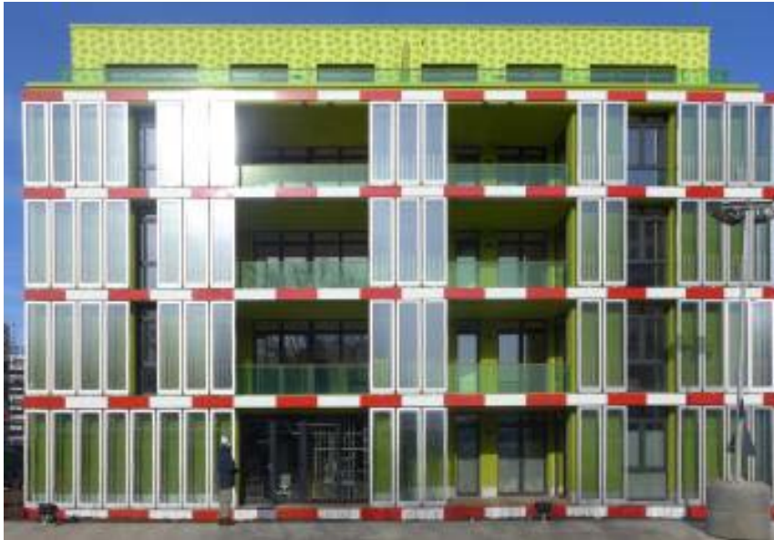
Das BIQ Haus: Weltweit erstes Fassadensystem zur Kultivierung von Mikroalgen zur Erzeugung von Wärme und Biomasse als erneuerbare Energiequelle. Foto: SolarLeaf (c) Arup
